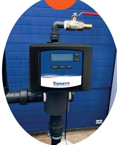
Raccorder le tuyau égout sur le raccord cannelé de la vanne
